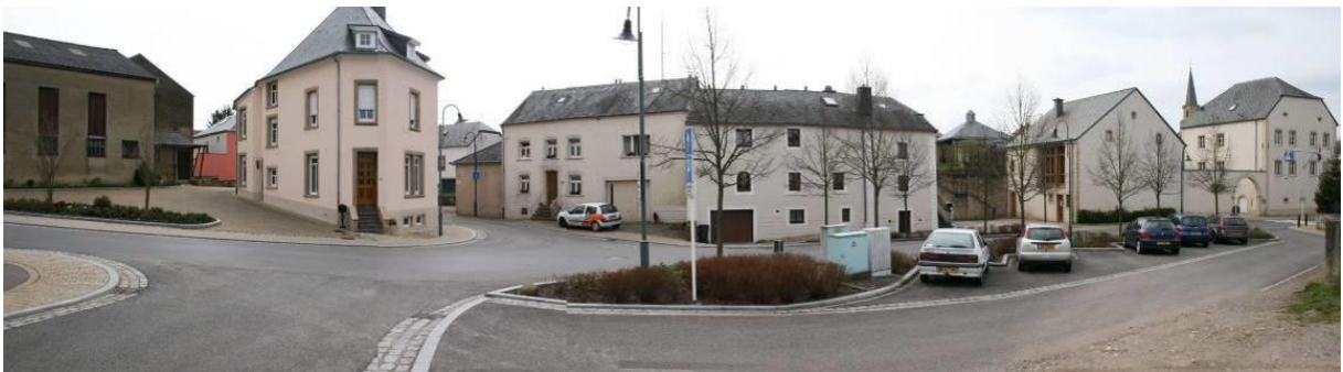
Photo 25 - Parking devant l'Administration Communale de Heffingen
