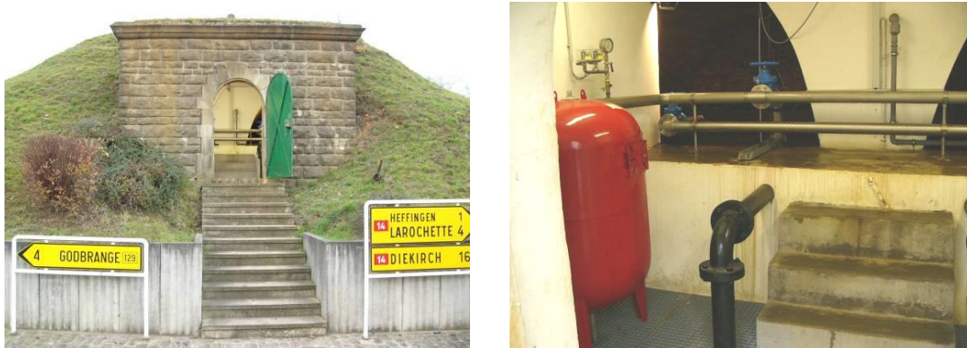
Photo 29 - Extérieur et intérieur du réservoir d'eau d'Heffingen
