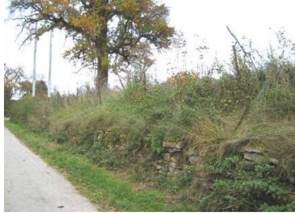
Photo 53 - Poirier ancien et mur en moellons sans jointolement le long d'une pâture à limite nord du périmètre, protégé au titre de l'article 17 comme « arbre remarquable » et « mur en pierre sèche »
