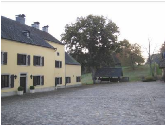
Photo 46 - Ancienne ferme à « Scherfenhaff » avec cour intérieure et arbres isolés anciens
