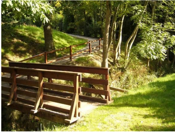
Photo 61 - Pont au-dessus de l'espace vert le long de la Wisbech et chemin piétonnier
